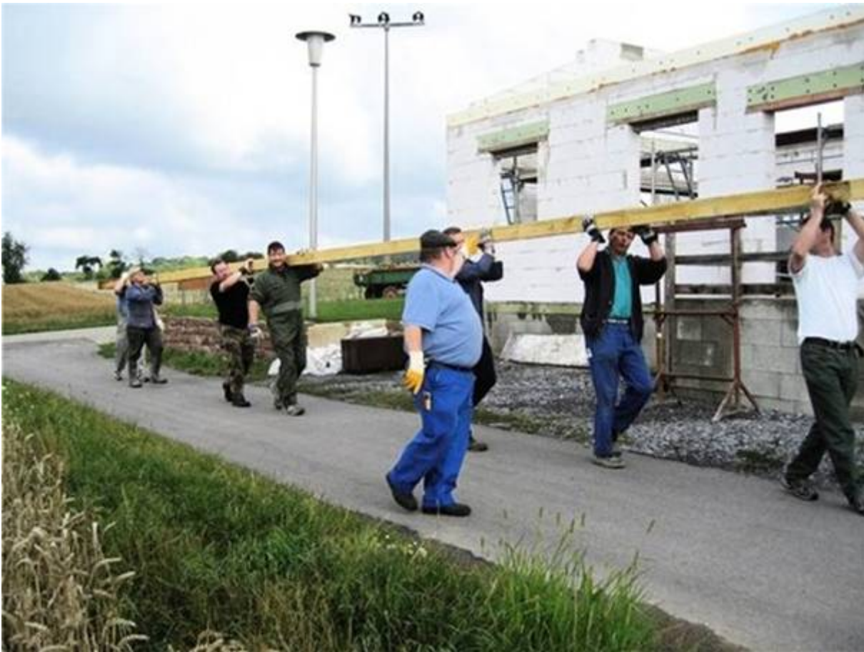
Bauphase: Nicht nur der Dachstuhl des Vereinsheims wurde 2005 in Eigenleistung erstellt. Foto: Privat
